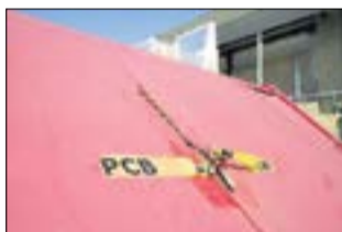
Alt byggeaffaldet puttes i en aflåst container inden det køres til Nord i Nyborg.
