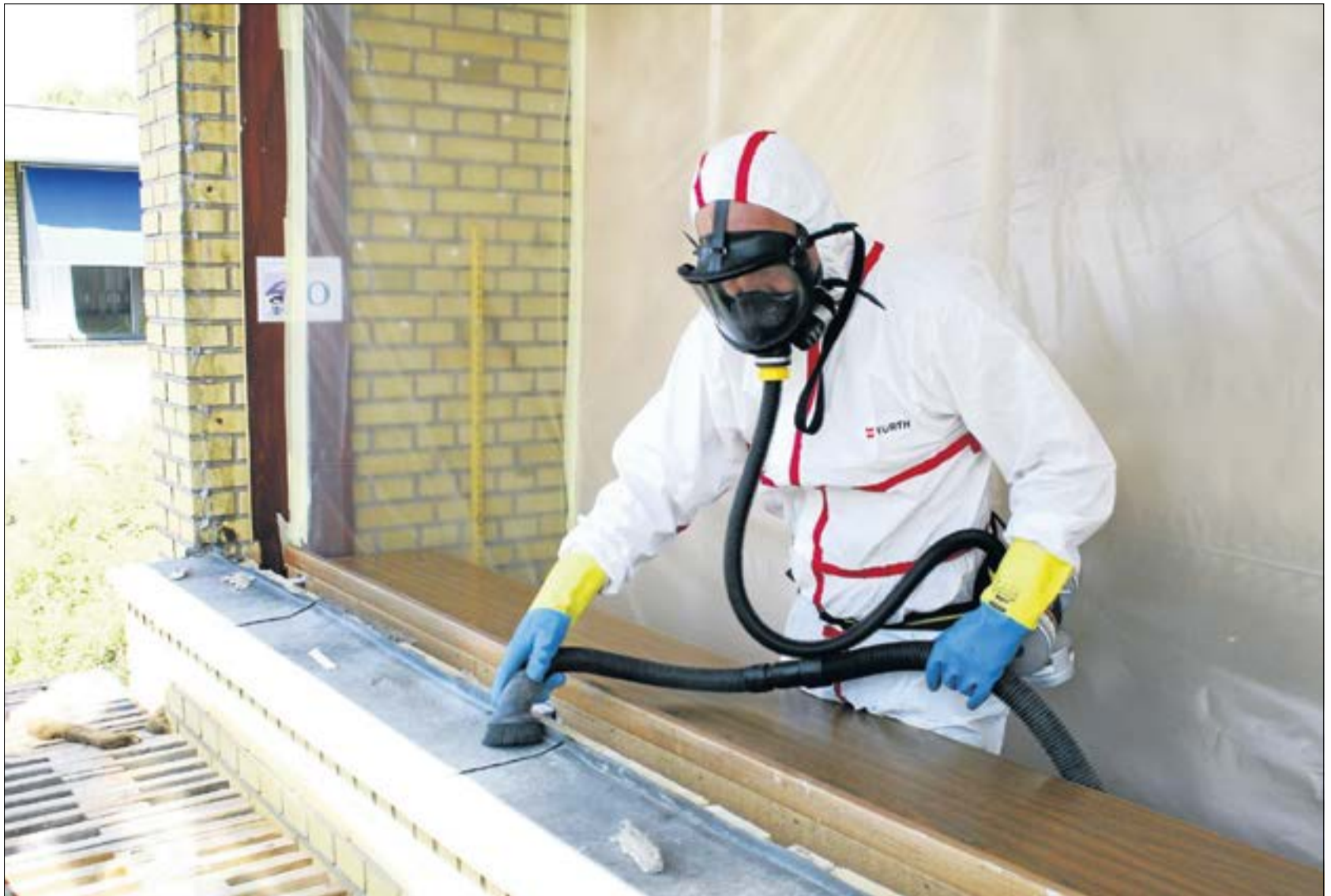
Det kræver en særlig dragt, handsker og åndedrætsværn, når de pcb-fyldte vinduer skal fjernes. Her bliver det sidste støv suget væk.
